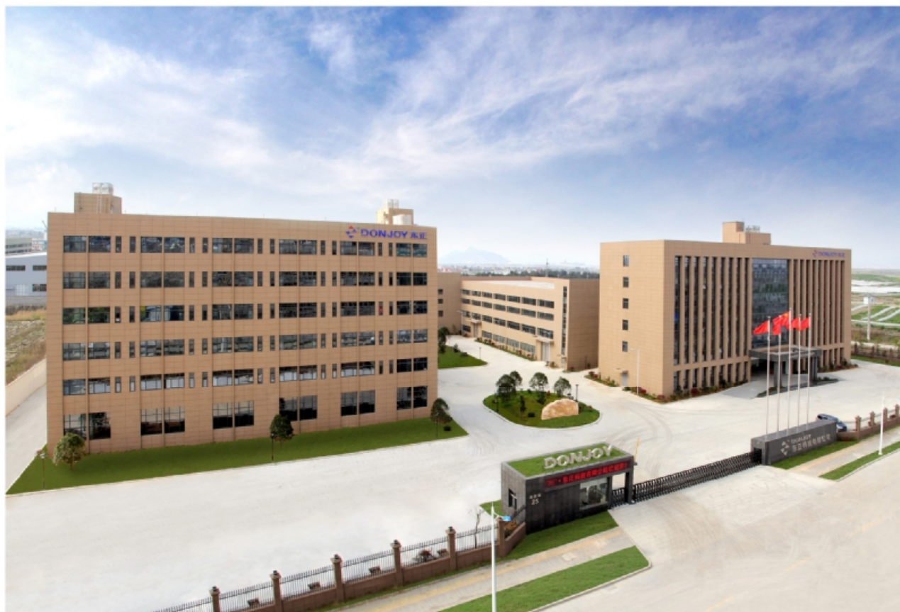
现代化工厂已经投产，期待您的光临！ 温州空港经济园区生产基地 Wenzhou airport economic zone production base
